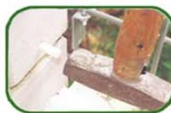
В отверстие вставить распорную часть от дюбель-гвоздя и забить ее молотком пока поверхность распорной части не сравняется с поверхностью стены. Повторить со всеми отверстиями.
