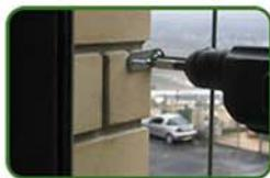
Крепим зажим к U-образной скобе (притягивая решетку к скобе гайкой) и забиваем дюбель в распорную часть. Повторить со всеми крепежными элементами. Можно ослабить веревку.
