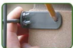
Примеряем крепежный элемент в проем, так чтобы зажим был перпендикулярен к поверхности крепления. Отметить точки под дальнейшие отверстия. Повторить действие со всеми крепежными элементами.
